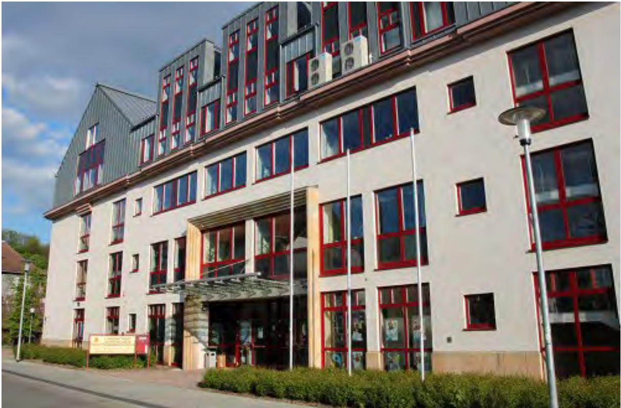
Neues Landratsamt, Behringstraße 3
